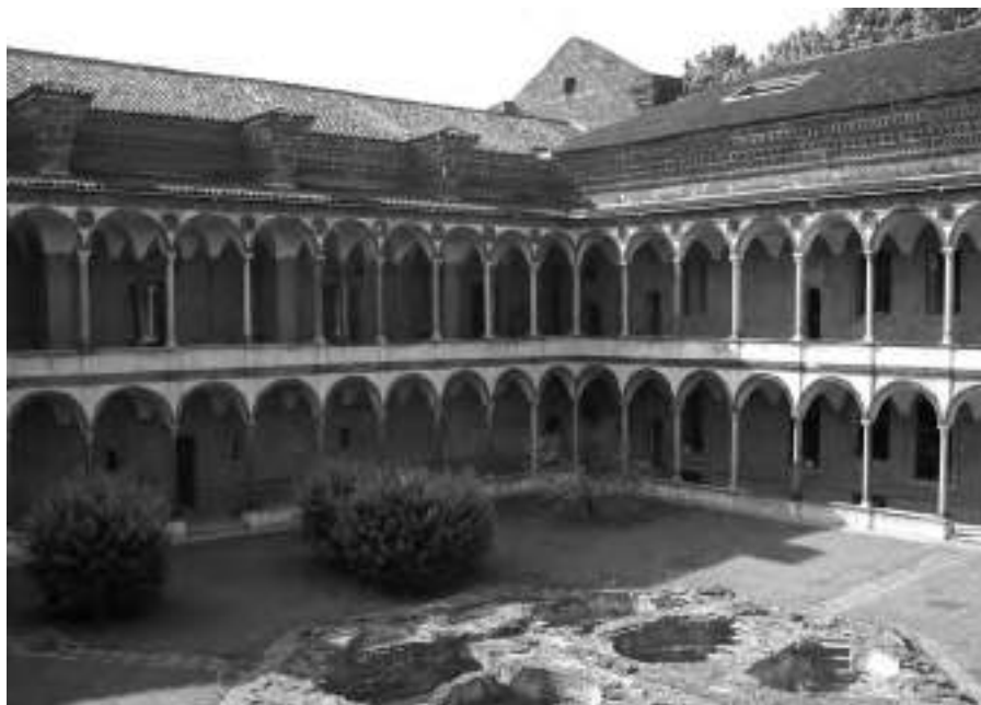
14. Cortile Bagni del Filarete, sede attuale di una parte degli Istituti della Facoltà di Giurisprudenza.
